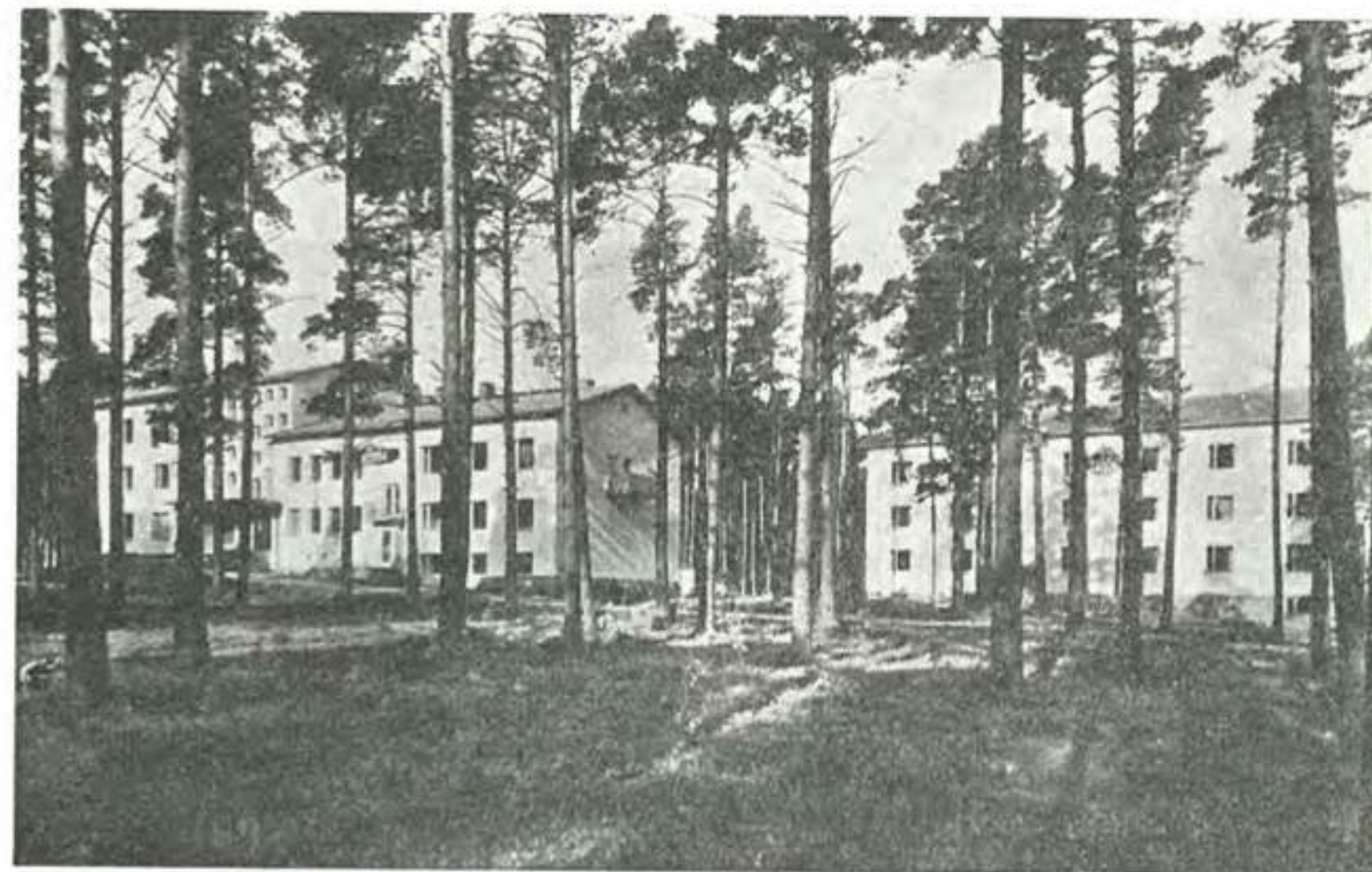
Porin diakonissalaitoksen rakennuksia.
