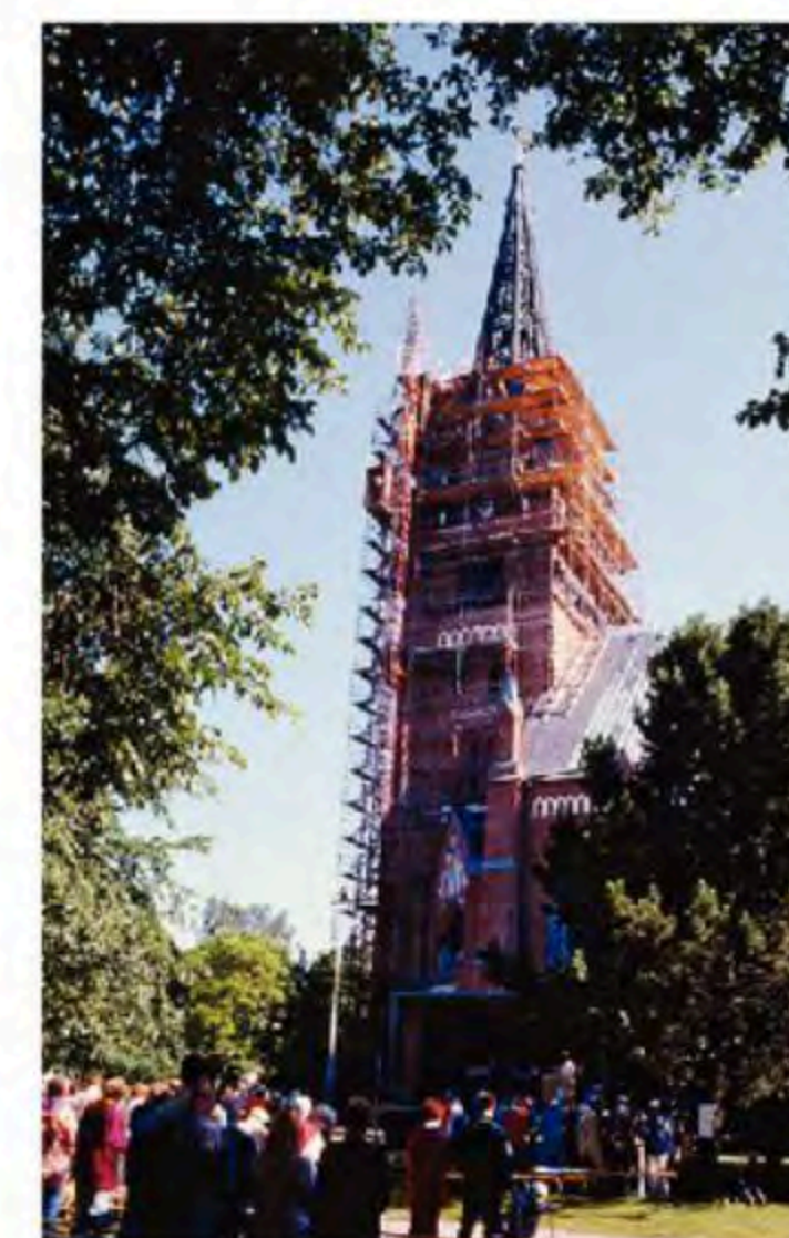
Tornikin lujittui 1990-luvun peruskorjauksessa.
