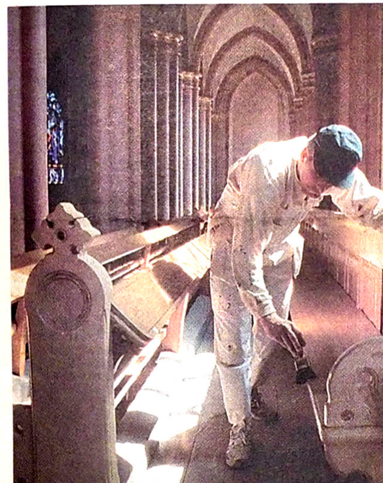
Penkkien korjaamiseen tarvittiin toistakymmentä työvaihetta: hionta, maalikerros, hionta. Lopuksi penkit ootattiin ja päättyyn maalattiin peilikuvio. Penkkien parissa Hannu Jänisoja
