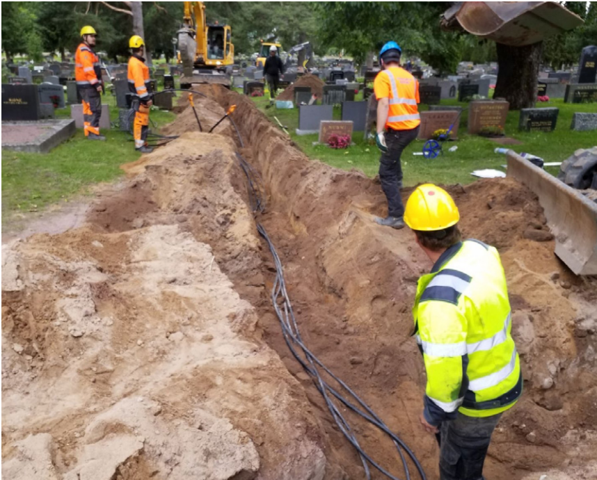
Nelisen kuukautta kestäneen Käppärän hautausmaan remontin aikana maahan kaivettiin uudet sähköjohdot aluesähköistyksen uusimisen tiimoilta.
