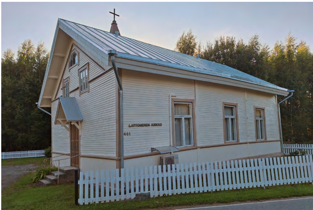
Lattomeren kirkon ulkoinen ilme on ulkoseinien taannoisen maalaamisen ansiosta kohentunut ratkaisevalla tavalla.
