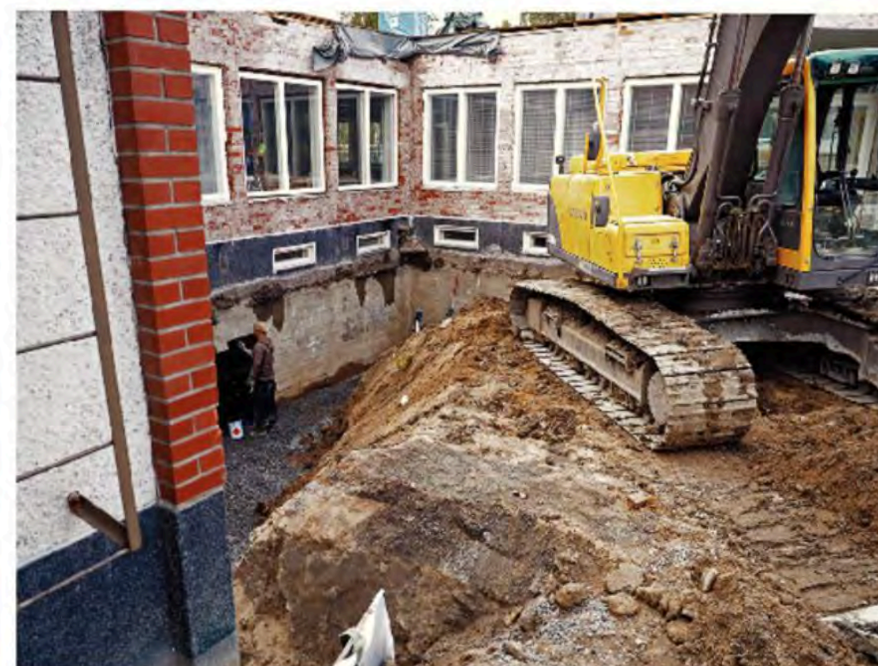
Länsi-Porin kirkon vesieristystöiden maankaivuut vaikuttavat kulkureitteihin.
