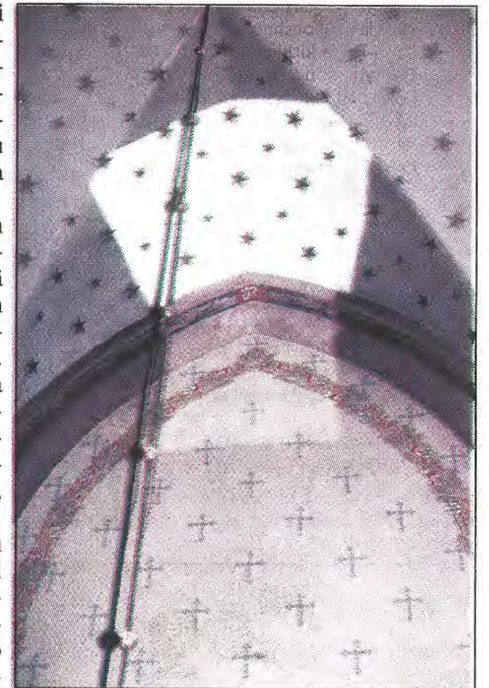
Holvikattoon tehty puhdistuskokeilu osoittaa, että kirkon taivas ja seinät ovat kirkastumassa huomattavasti.
