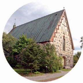
Noormarkun kirkko Vanha Vaasantie 1
