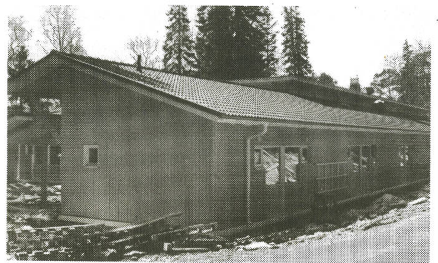
Kulmat elävöittävät Junnilan uutta majoitusrakennusta, joka valmistuu vielä toukokuun aikana.
