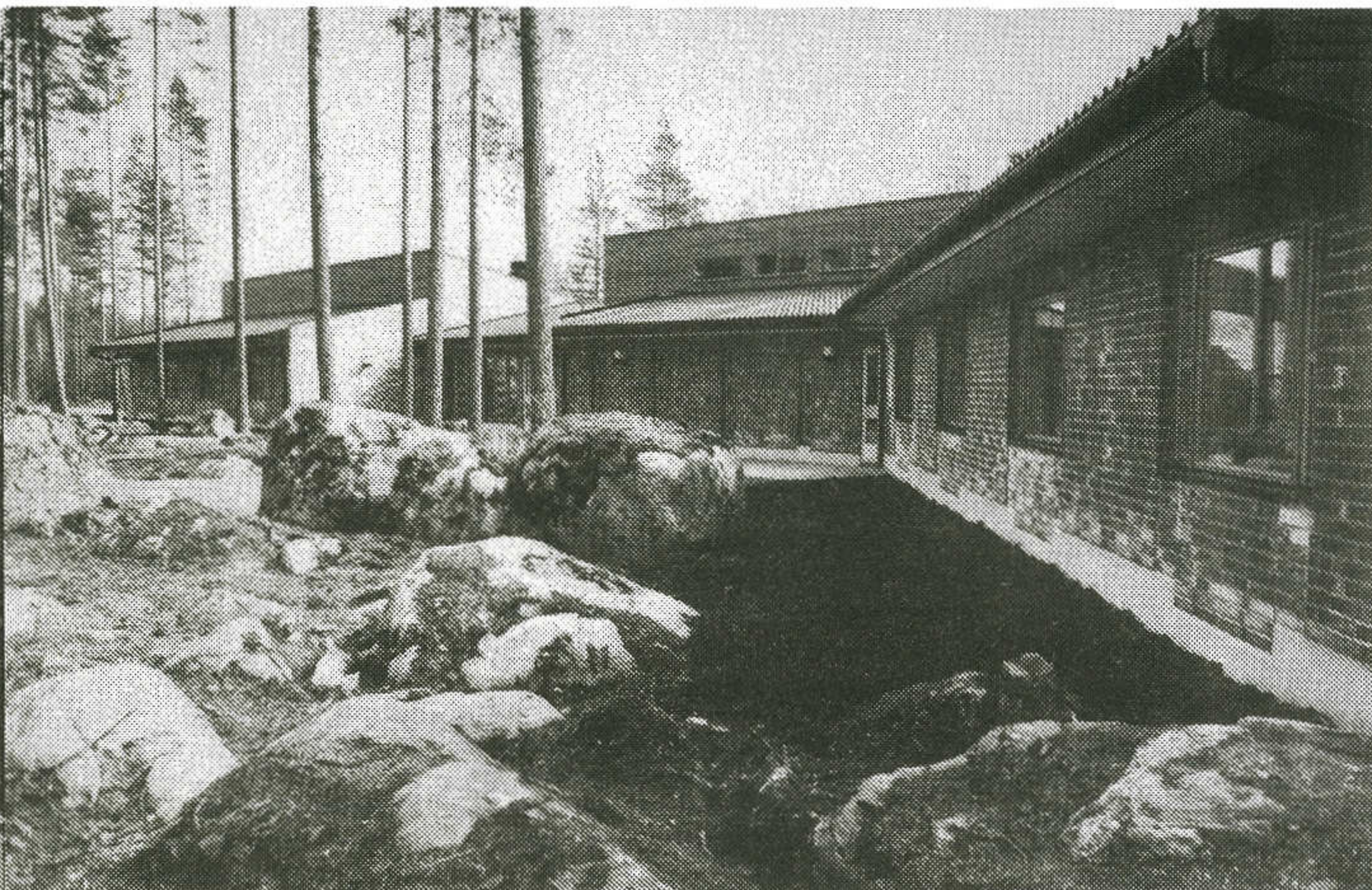
Majoitusrakennuksia Silokalliossa on kaksi. Kummassakin on kaksi osaa, joita yhdistää moneitoimitila. Majoitushuoneita on 40 ja yhteen huoneeseen voidaan majoittaa kahdesta neljään henkilöä.
