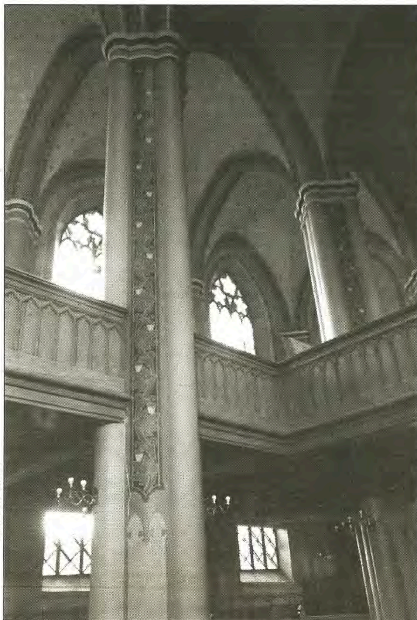
Keski-Porin kirkon peruskorjaus valmistuu niin, että ensi vuoden adventin "Hoosianna" soi jo uudistuneessa kirkkosalissa. Jo nyt kirkon ilme on muuttunut, sillä ikkunarudut on vaihdettu ja katto puhdistettu. Korjaukseen on rahastoitu varjoja jo monessa budjetissa. Kokonaiskustannuksiltaan 17 miljoonaan markkaan nousevaan peruskorjaukseen tarvitaan ensi vuonna myös lainaa.
