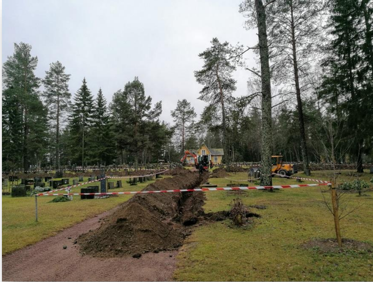
Kuva 9 Ahlaisten uuden hautausmaan sähkönjakelun ja valaistuksen uusiminen.
